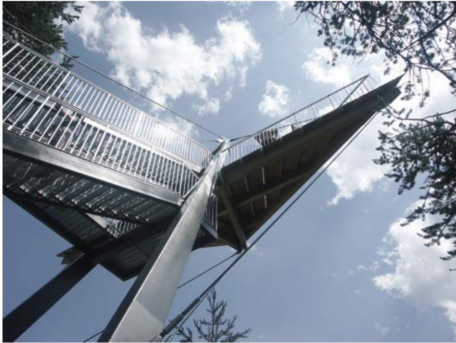
Die filigrane, in dunklen Tönen gehaltene Stahlkonstruktion mit der mit Holzsparren belegten Plattform ragt 12,5 m in den Himmel und über die steile Geländekante hinaus, fast 400 m über der Rheinschlucht.
